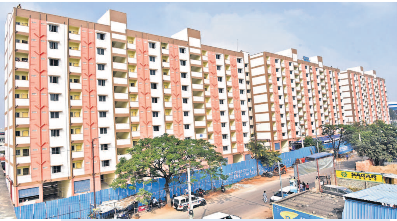
వనస్థలిపురంలో నిర్మించిన డబుల్ బెడ్రూం ఇండ్ల సముదాయం
