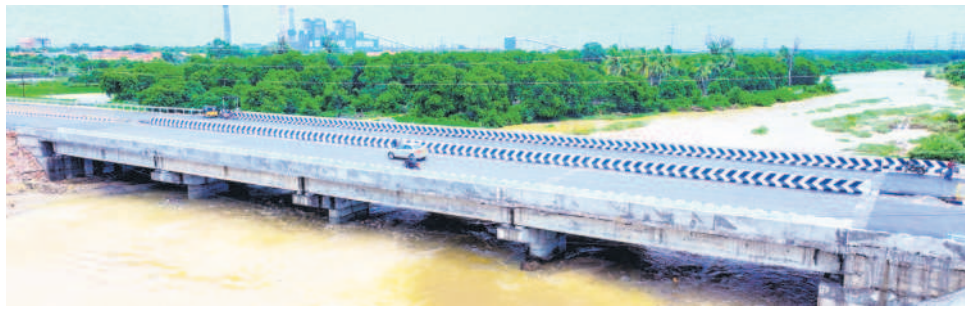
జైపూర్ మండలం రసూర్పల్లి ధర్న వాగుపై నిర్మించిన బ్రిడ్జి
