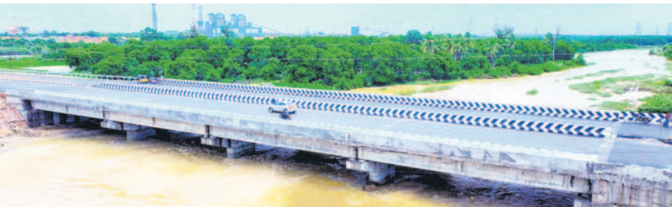
జైపూర్ మండలం రసూర్ పల్లి ధర్మ వాగుపై నిర్మించిన బ్రిడ్జి
