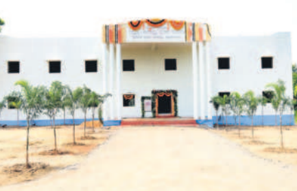
మండలంలో నిర్మించిన 'సమ్మక్క-సారలమ్మ' మహిళా భవన
