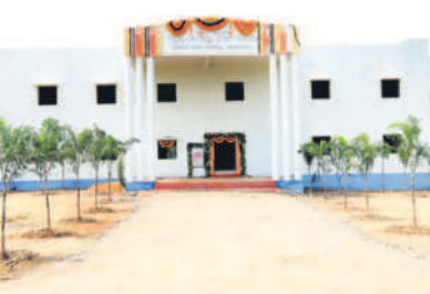
మండలంలో నిర్మించిన 'సమ్మక్క-సారలమ్మ' మహిళా భవన
