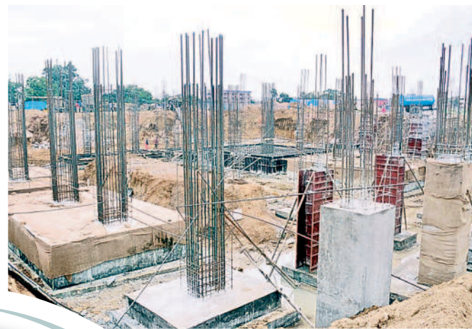
వరంగల్లో చకచకా సాగుతున్న ఐడీవోసీ నిర్మాణ పనులు
