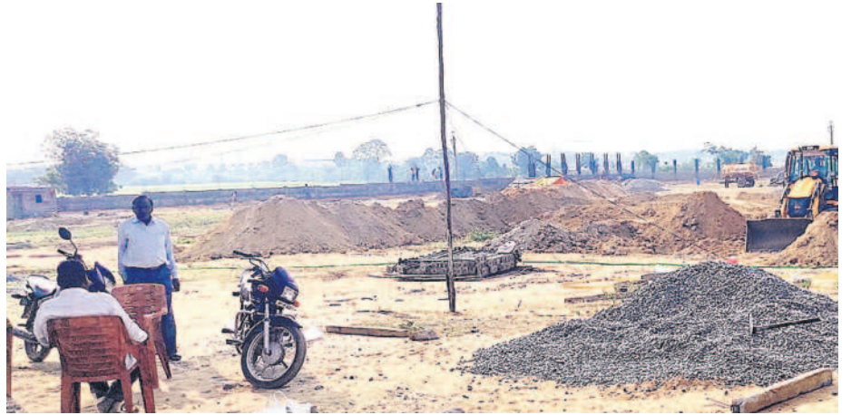
శరవేగంగా సాగుతున్న బస్ డిపో నిర్మాణం పనులు
