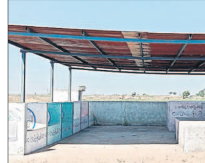
గ్రామంలో నిర్మించిన సెగ్రిగేషన్ షెడ్
