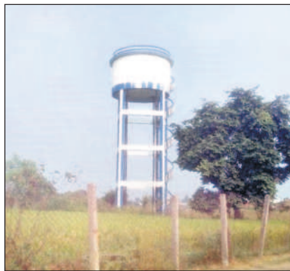
గ్రామంలో నిర్మించిన మిషన్ భగీరథ వాటర్ ట్యాంక్
