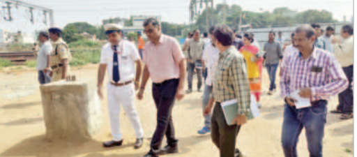
జడ్డర్ లో రైల్వే అండర్ బ్రిడ్జి నిర్మాణ పనులను పరిశీలిస్తున్న డీఆర్ఎం
