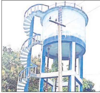
గ్రామంలో నిర్మించిన మిషన్ భగీరథ వాటర్ ట్యాంక్
