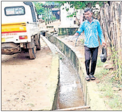
నూతనంగా నిర్మించిన డ్రైనేజీ
