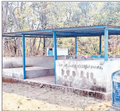
గ్రామంలో నిర్మించిన సెగ్రిగేషన్ షెడ్
