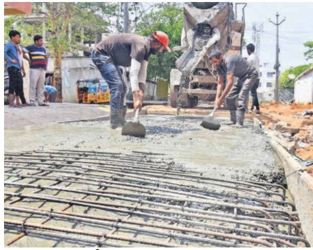
కర్నాటపూట్ గ్రీన్ పార్క్ కాలనీలో కొనసాగుతున్న నాలా పనులు
