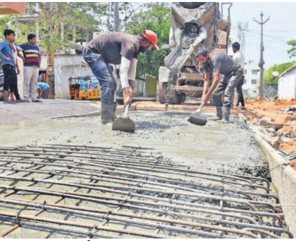
కర్నాటపూట్ గ్రీన్ పార్క్ కాలనీలో కొనసాగుతున్న నాలా పనులు
