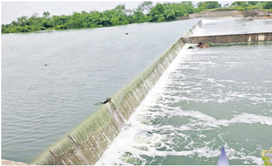
చిలిపిచెడ్డ మండలంలో మంజీరా నదిపై నిర్మించిన చెక్ డ్యామ్
