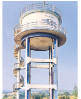
నేడు పుట్టిగూడెంలో నిర్మించిన మిషన్ భగీరథ ట్యాంక్
