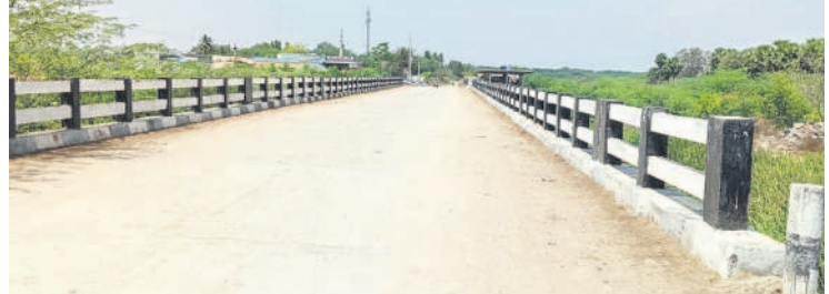
పన్నూరు వాగుపై నిర్మించిన బ్రిడ్జి
