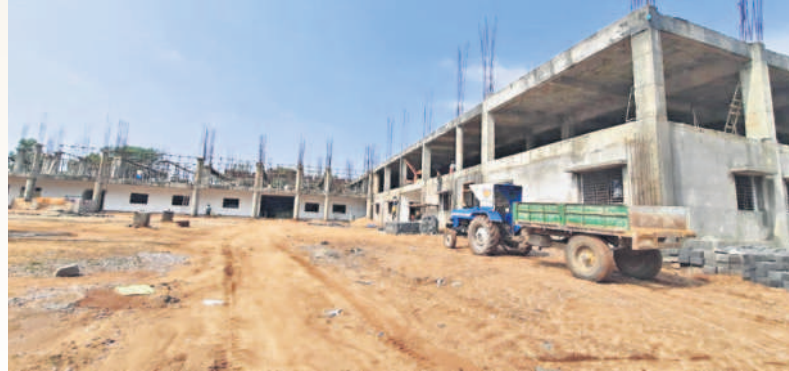
చేర్యాలలో నిర్మాణ దశలో ఉన్న సమీకృత ప్రభుత్వ కార్యాలయాల భవన సముదాయం
