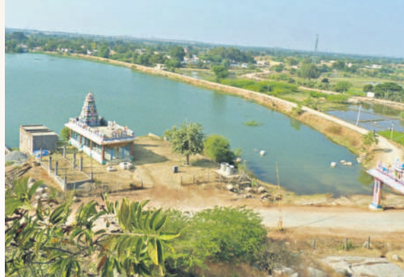
మిషన్ కాకతీయ పనులతో చెరువులోకి చేరిన గోదావరి జలాలు
