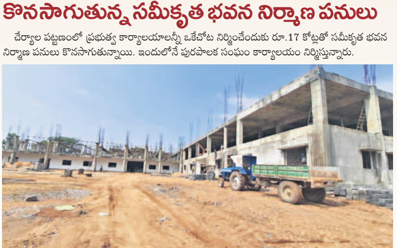
చేర్యాలలో నిర్మాణ దశలో ఉన్న సమీకృత ప్రభుత్వ కార్యాలయాల భవన సముదాయం
