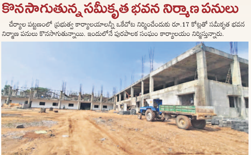
చేర్యాలలో నిర్మాణ దశలో ఉన్న సమీకృత ప్రభుత్వ కార్యాలయ భవన సముదాయం
