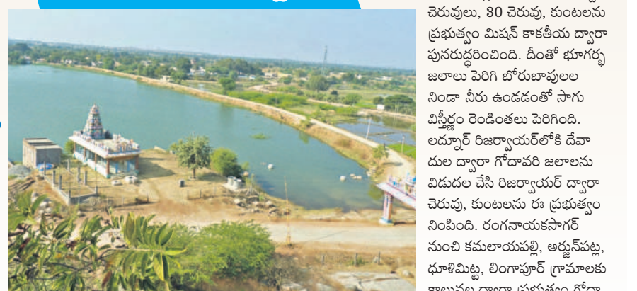
మిషన్ కాకతీయ పనులతో చెరువులోకి చేరిన గోదావరి జలాలు
