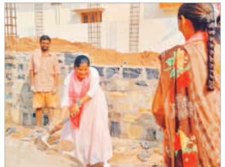
శాంతినగర్లో ఇంటినిర్మాణ పనులు చేస్తున్న చైర్మన్ కరుణ
