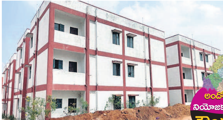
జోగిపేటలో నిర్మించిన డబుల్ బెడ్రూం ఇండ్లు
