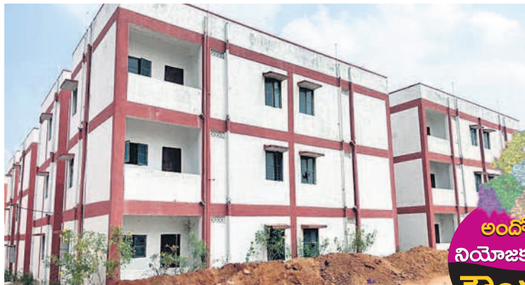
జోగిపేటలో నిర్మించిన డబుల్ బెడ్రూం ఇండ్లు
