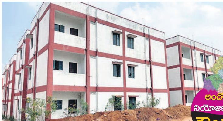
జోగిపేటలో నిర్మించిన డబుల్ బెడ్రూం ఇండ్లు
