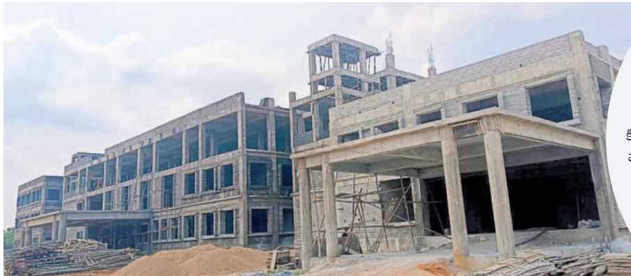
నకిరేకల్ పట్టణంలో జరుగుతున్న 100 పడకల దవాఖాన నిర్మాణ పనులు
