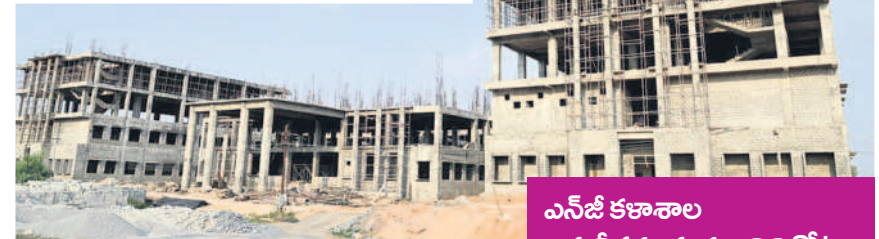
నిర్మాణంలో ఉన్న మెడికల్ కాలేజీ భవనం
