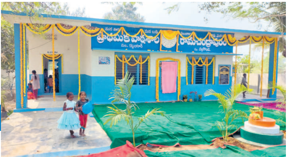
మన ఊరు-మన బడి కార్యక్రమంలో భాగంగా నూతన శోభ సంతరించుకున్న కట్టంగూర్ మండలంలోని రామచంద్రాపురం పాఠశాల
