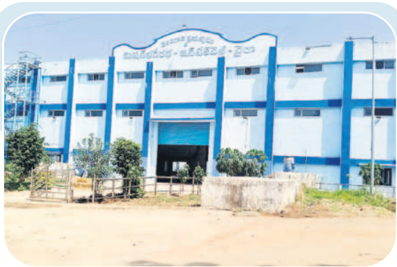
వైరా రిజర్వాయర్ వద్ద నిర్మించిన మిషన్ భగీరథ ఇన్ టేక్ వెర్
