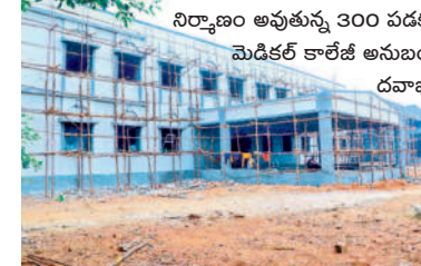
నిర్మాణం అవుతున్న 300 పడకల మెడికల్ కాలేజీ అనుబంధ దవాఖాన
