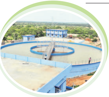
షాబాద్ మండలం అంతారం వద్ద ఏర్పాటు చేసిన మిషన్ భగీరథ తాగునీటి సరఫరా ప్రాజెక్టు
