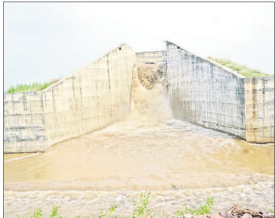
చనాక- కొర్రాట ప్రాజెక్టు ట్రయల్ రన్
