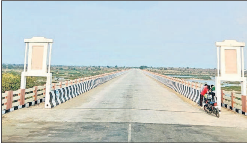
చింతలమానేపల్లి మండలంలో గూడెం గ్రామం వద్ద నిర్మించిన అంతర్జాతీయ వంతెన
