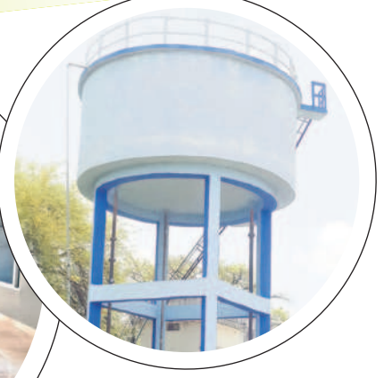
మిషన్ భగీరథ ట్యాంకు
