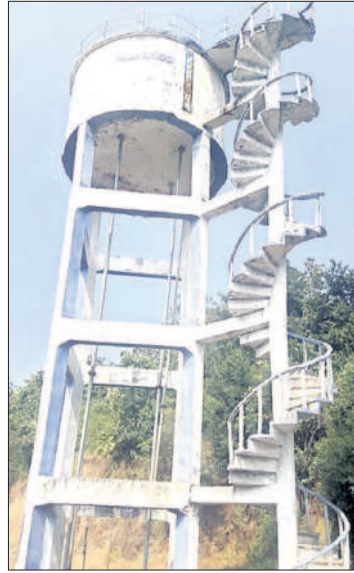
నిర్మించిన మిషన్ భగీరథ వాటర్ ట్యాంక్
