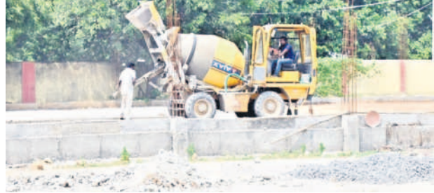
నూతన షెడ్ల నిర్మాణాలు
