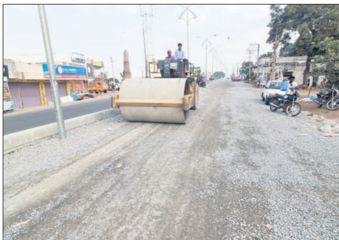
రుద్రంగిలో చివరి దశకు చేరుకున్న నాలుగు లైన్ల బీటీరోడ్డు పనులు
