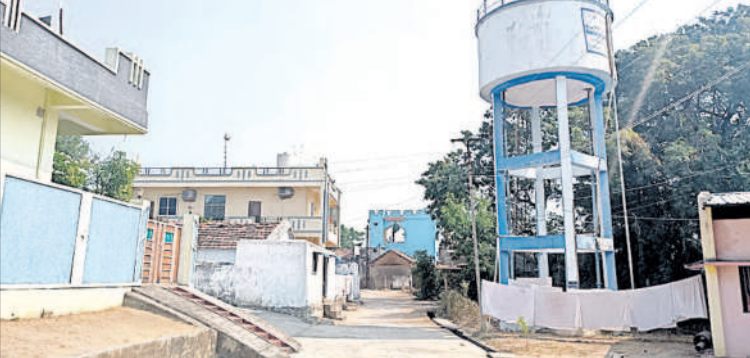
హస్నాపూర్ గ్రామంలో నిర్మించిన సీసీ రోడ్డు
