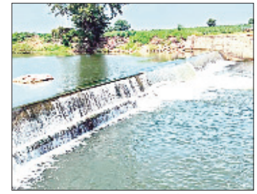
హస్నాపూర్ గ్రామంలో రూ.కోటి 35 లక్షలతో నిర్మించిన చెక్ డ్యాం
