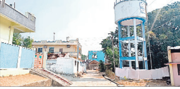
హస్నాపూర్ గ్రామంలో నిర్మించిన సీసీ రోడ్డు
