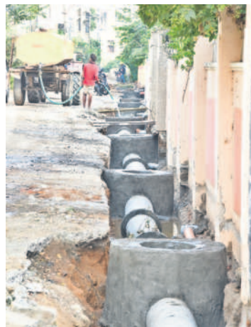
భాగ్యనగర్లో చేపడుతున్న అండర్ గ్రాండ్ డ్రైనేజీ పనులు
