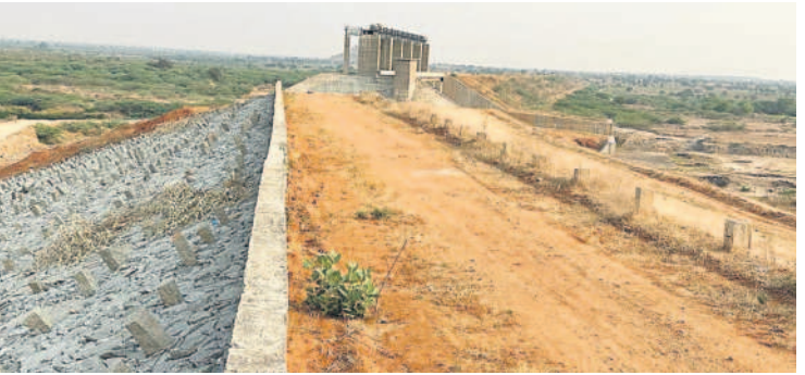
గొట్టిముక్కల రిజర్వాయర్ ఆనకట్టపై పూర్తయిన పనులు
