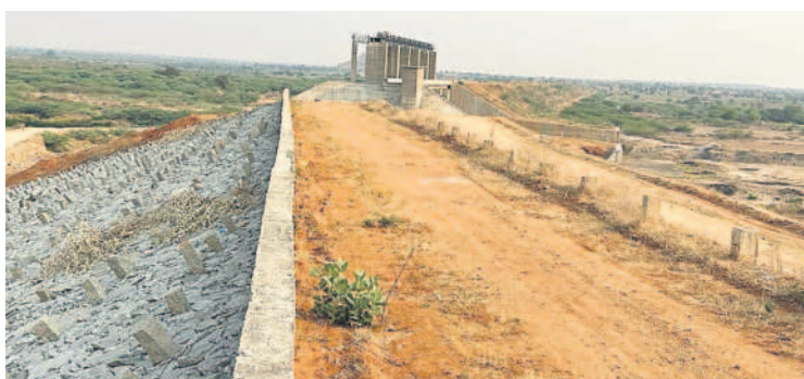
గొట్టిముక్కల రిజర్వాయర్ ఆనకట్టపై పూర్తయిన పనులు
