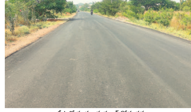
రాజాపేటలో పూర్తయిన డబుల్ రోడ్డు పనులు
