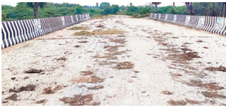
మారుపాక - గోవిందన్నగూడెం గ్రామాల నడుమ నిర్మించిన హైలెవల్ వంతెన
