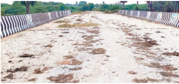
మారుపాక - గోవిందన్నగూడెం గ్రామాల నడుమ నిర్మించిన హైలెవల్ వంతెన
