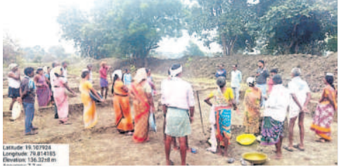
కుంట పనులను పరిశీలనను ఏఈవో సత్య ప్రసాద్
