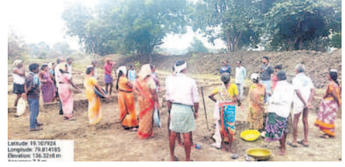
కుంట పనులను పరిశీలనను ఏఈవో సత్య ప్రసాద్
