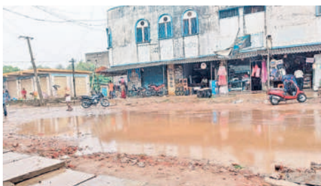
ఏటూరునాగారం : రోడ్డుపై నిలిచిన వరద నీరు
