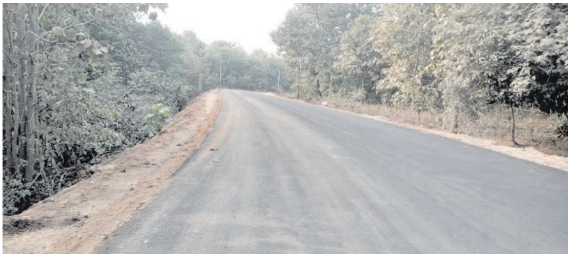
సిరికొండ నుంచి చీమనపల్లి వరకు నూతనంగా నిర్మించిన బీటీ డబుల్ రోడ్డు
