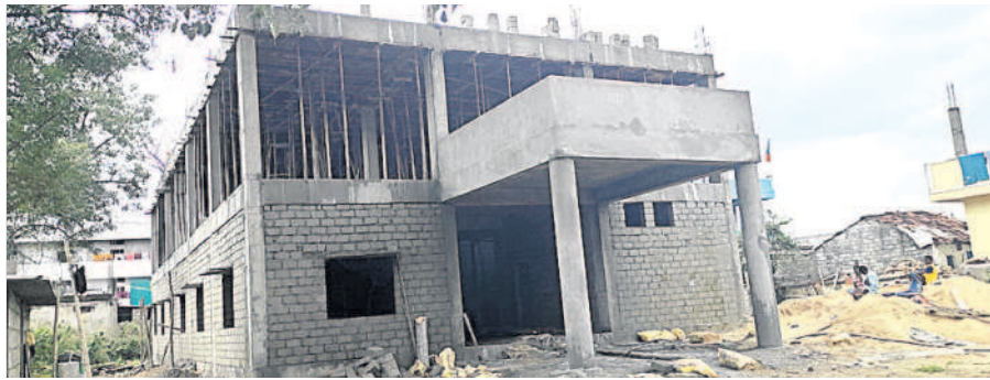
చెన్నూర్ పట్టణంలో కొనసాగుతున్న మహిళా భవన నిర్మాణ పనులు
