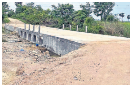
మల్లగూడెంలో నిర్మించిన కల్వర్టు
